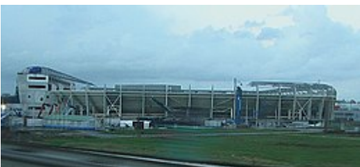
Het stadion in aanbouw, december 2006.
